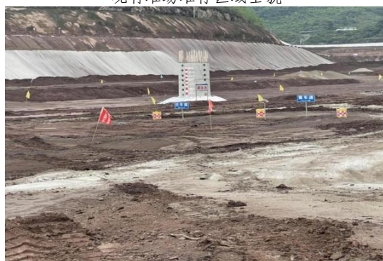
3#竖井及库内现状
