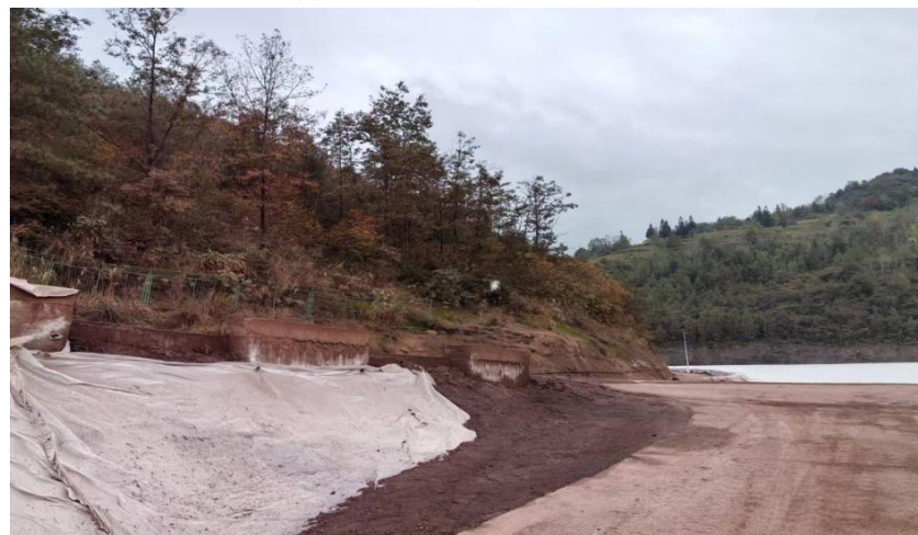
赤泥堆场北侧现场照片
