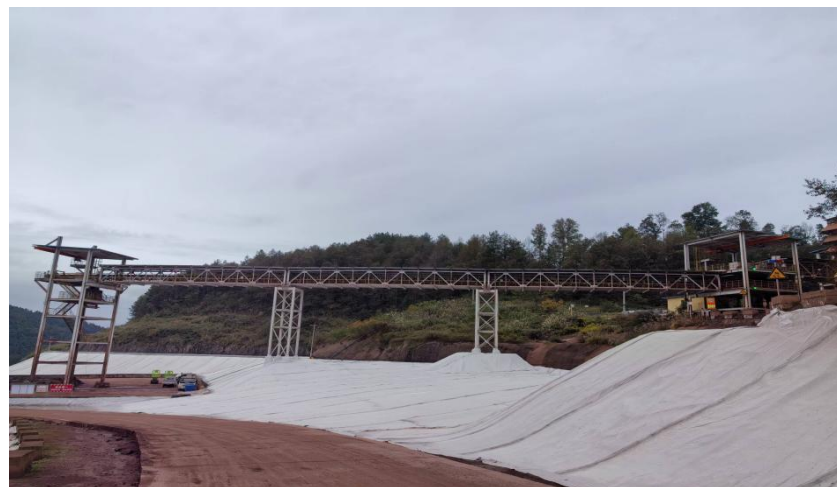
赤泥堆场西侧现场照片
