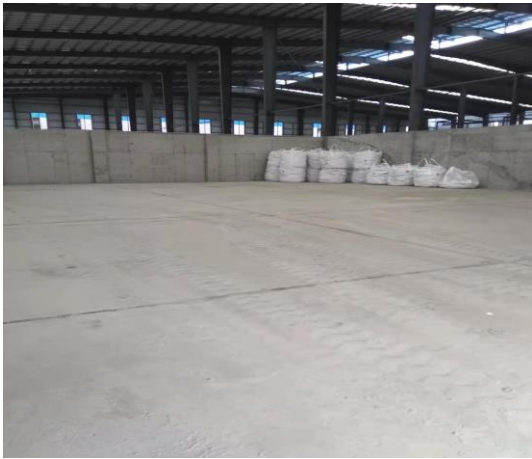
现有砷碱渣库
