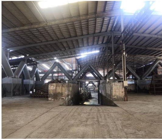
现有收尘管道
