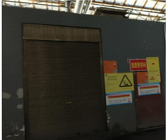
现有危险废物暂存库
