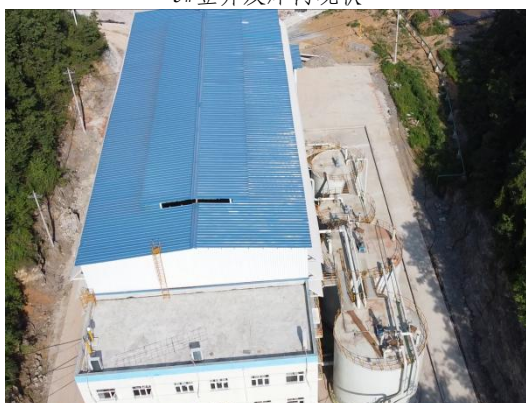
压滤车间及滤液槽
