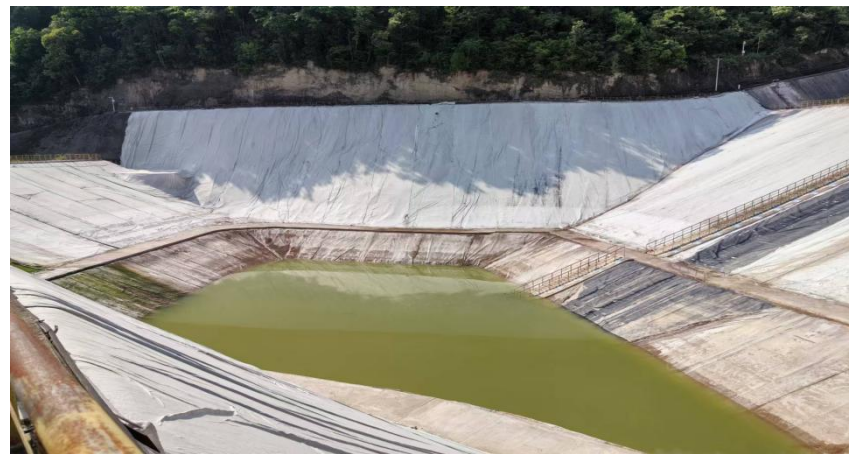
赤泥堆场回水池现场照片
