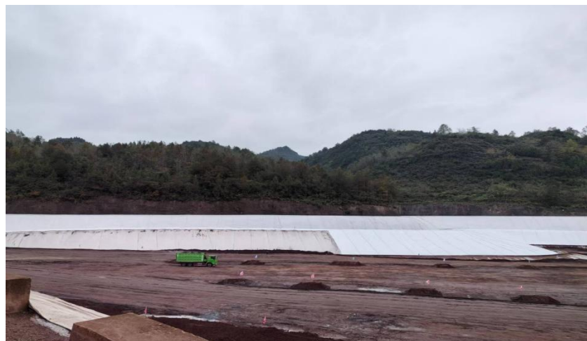
赤泥堆场东侧现场照片
