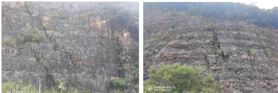
图 4.3-5 发育在场区周边山体上岩溶裂隙照片
