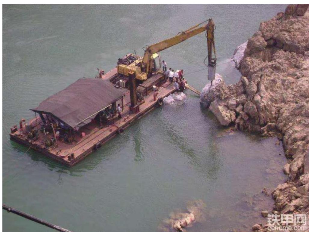
图 1.2-3 液压破碎锤施工
