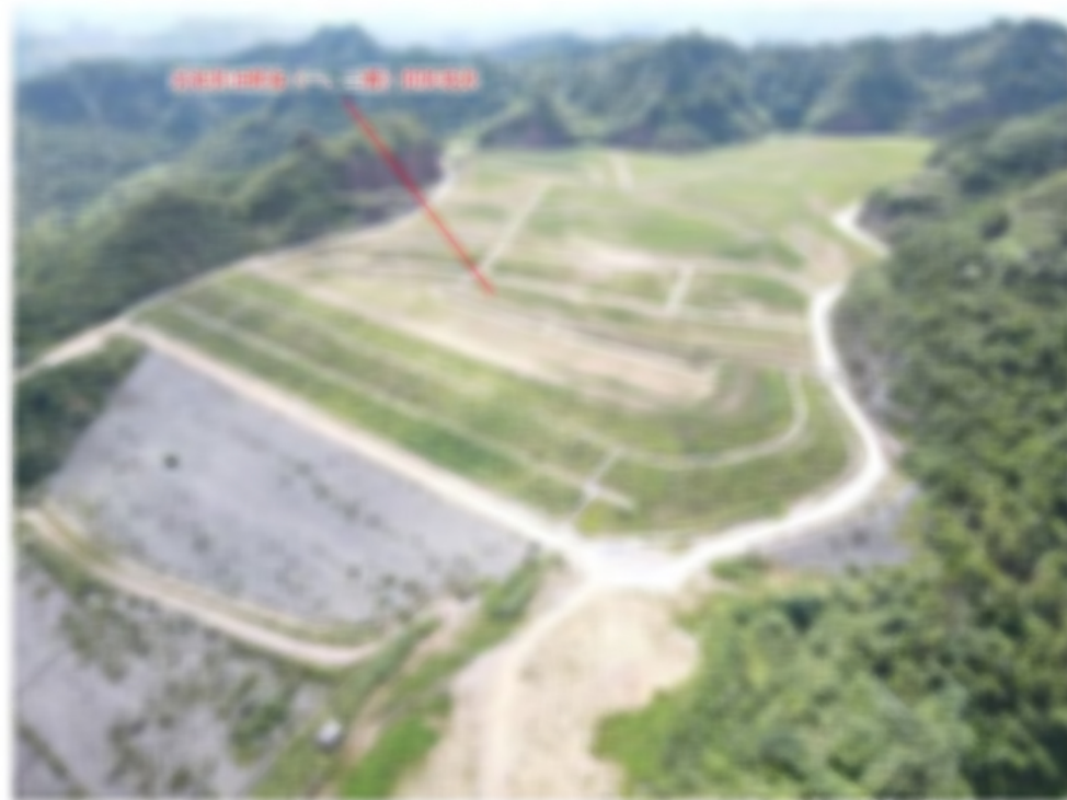
赤泥库 1#堆场（一、二期）闭库封场现状
