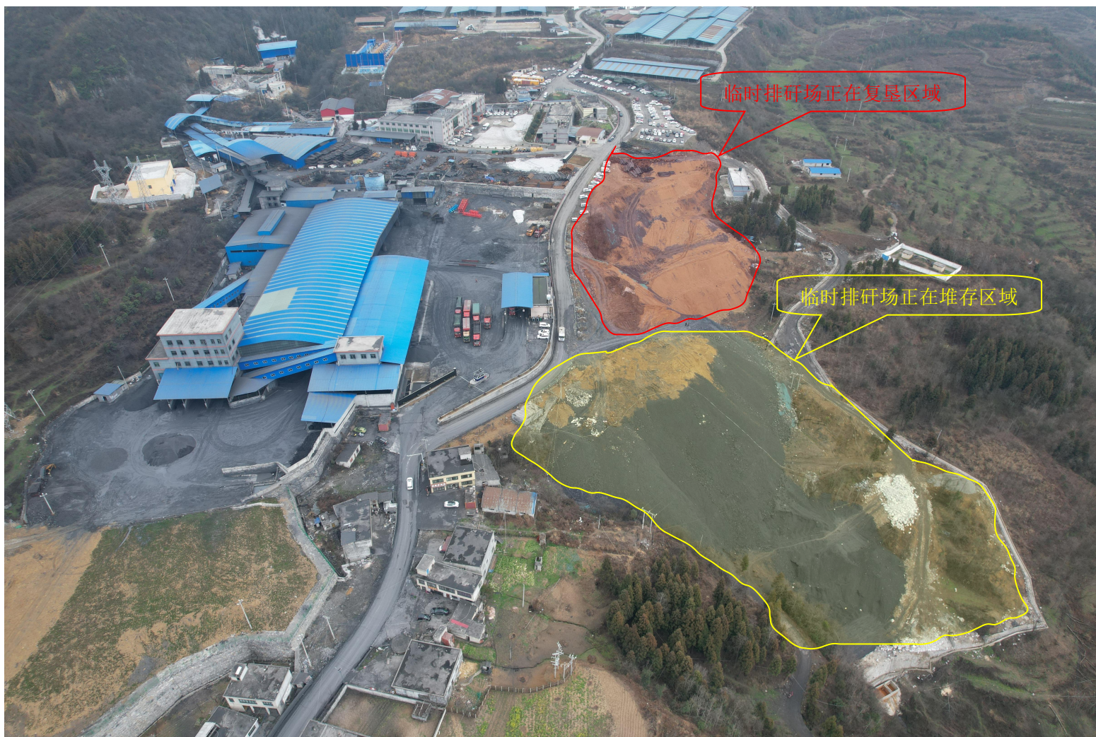
插图 2 安益煤矿临时排矸场现状
