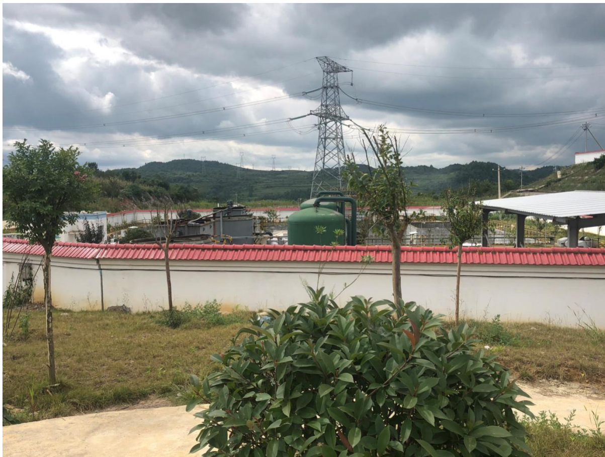
图 2.2-5 贵州华仁新材料有限公司污水处理站
