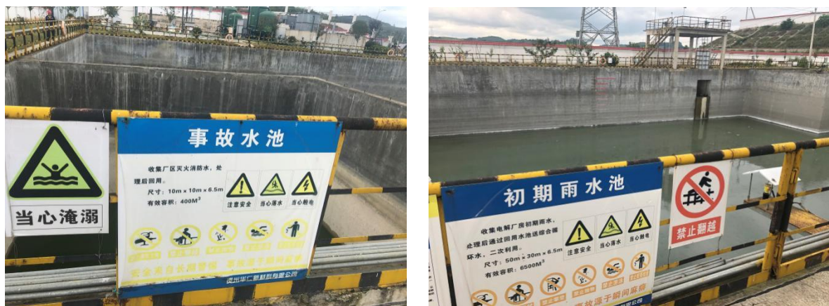
图 6.2-2 贵州华仁新材料有限公司事故水池（左）及初期雨水池（右）
