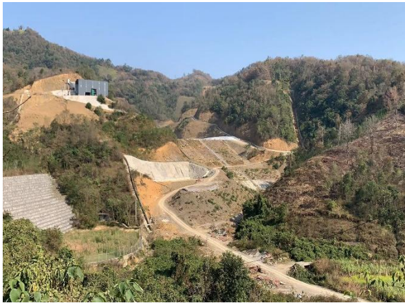
项目建设场地东面
