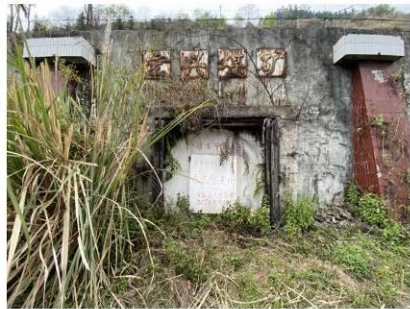
原宏兴煤矿放水平硐（已封闭）
