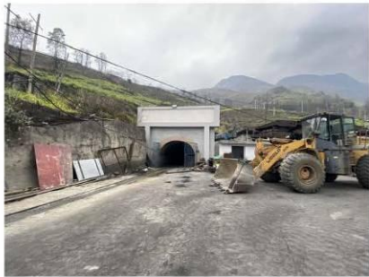
恒泰煤矿副平硐（利用）
