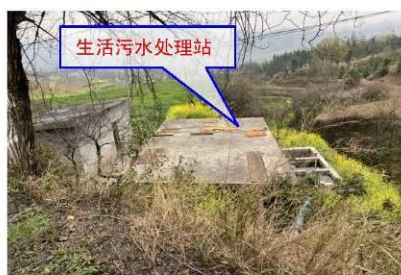
恒泰煤矿生活污水处理站
