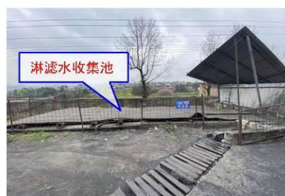
场地淋滤水收集池
