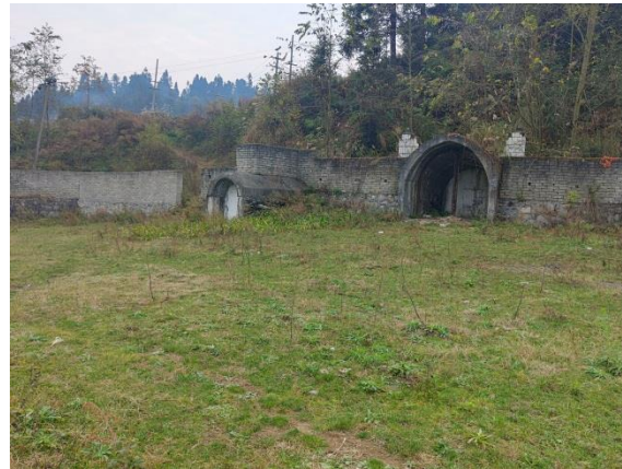
封闭井筒及复垦场地
