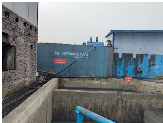
生活污水处理站
