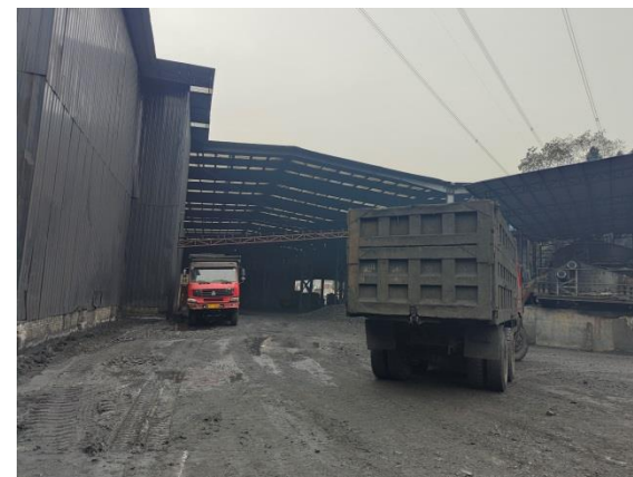
储煤场与装车场
