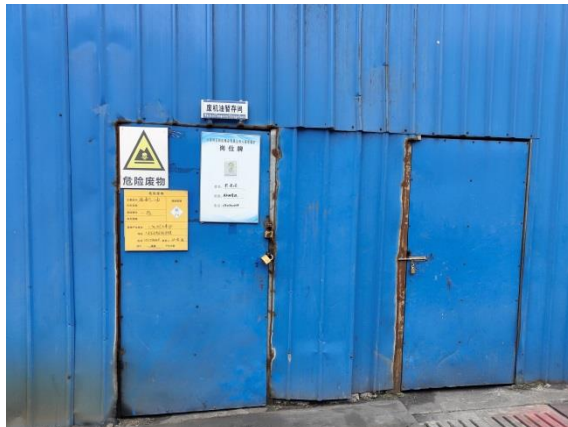
危险废物暂存间
