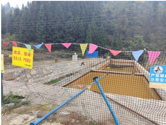
淋滤水池及事故水池
