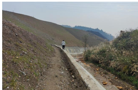
已复垦的老矸石山、截止排水沟及挡矸坝
