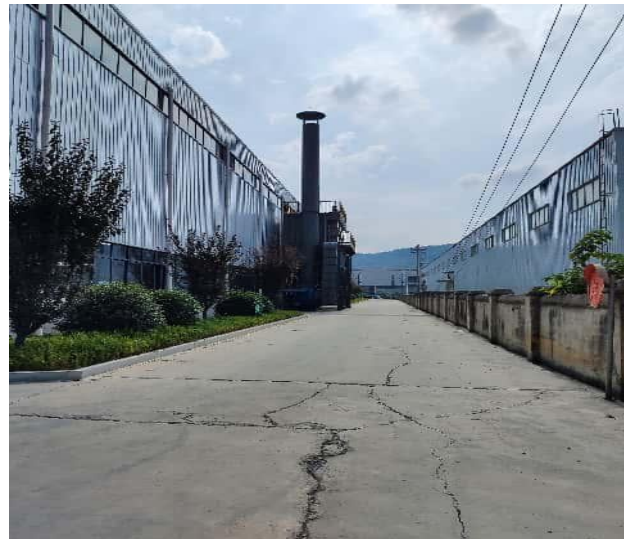
废料仓库新增排气筒
