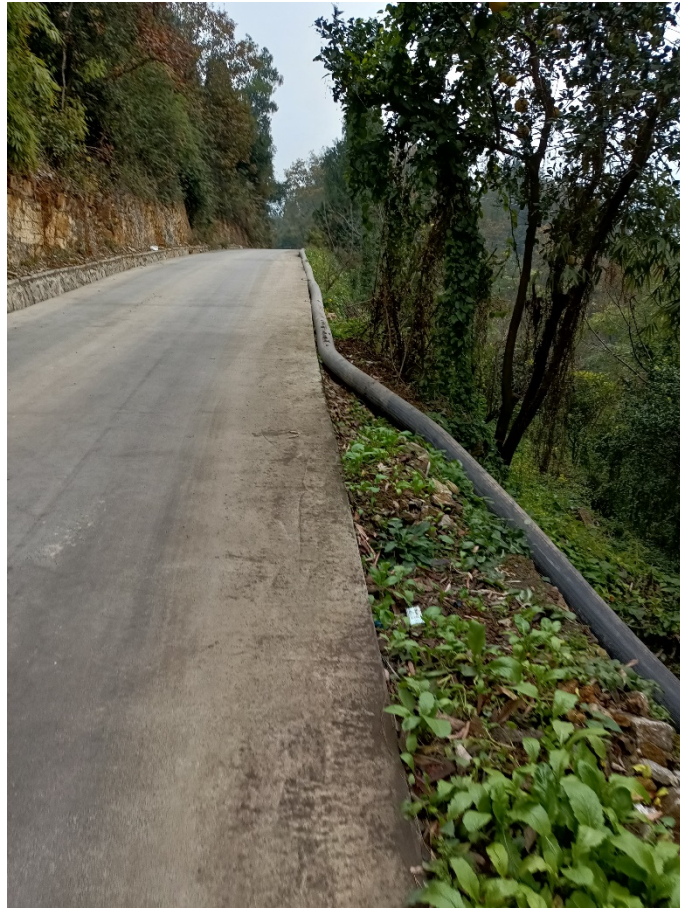
图 2.3-3 压裂供水临时软管敷设示例图
