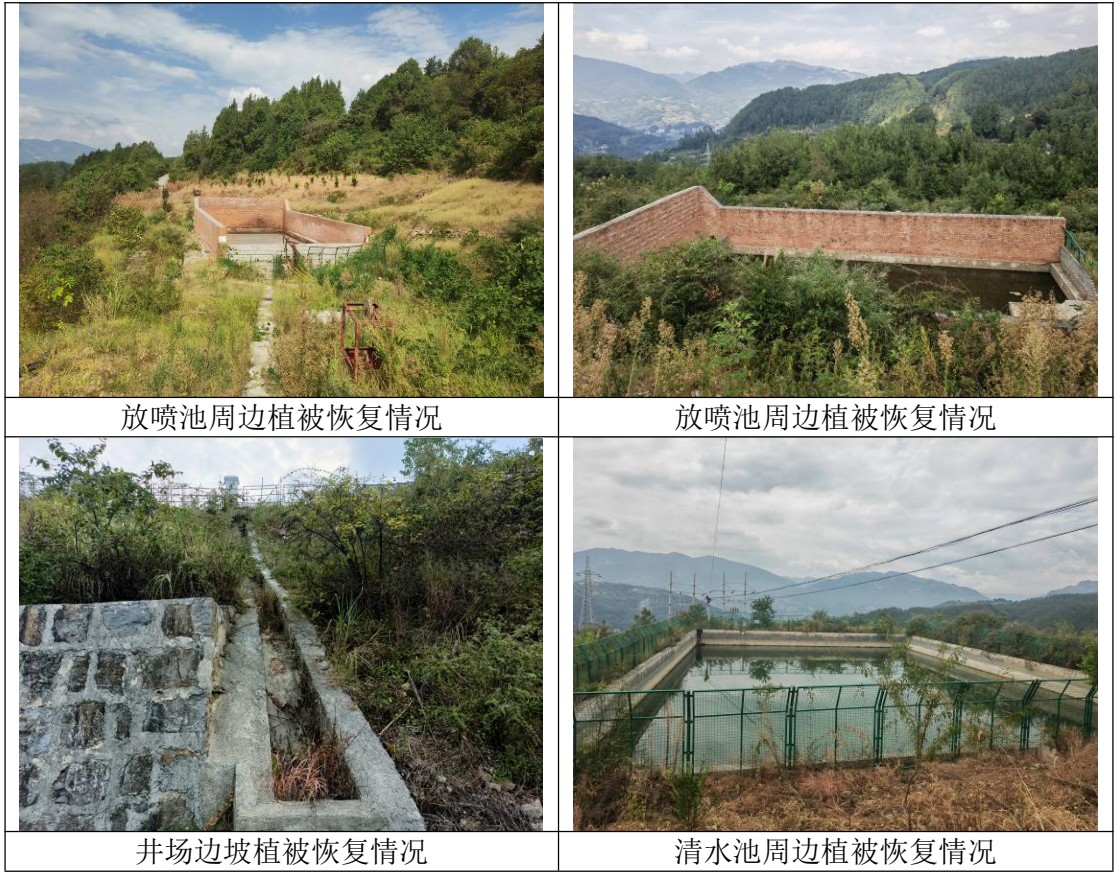
图 2.2-2 真页 1 平台生态恢复现状照片
