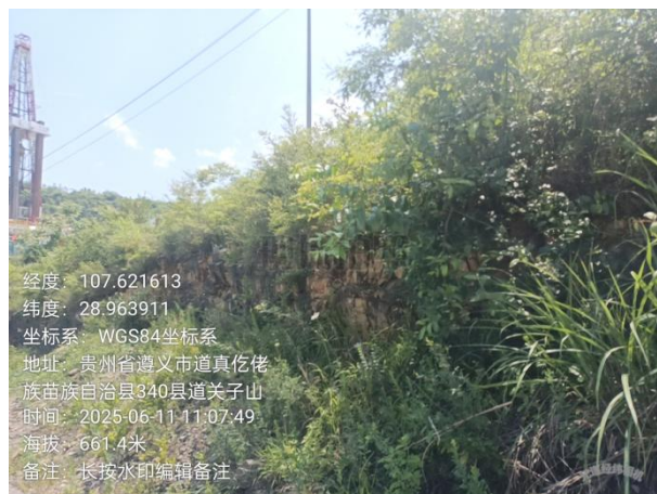
真页 1 平台边坡现状
