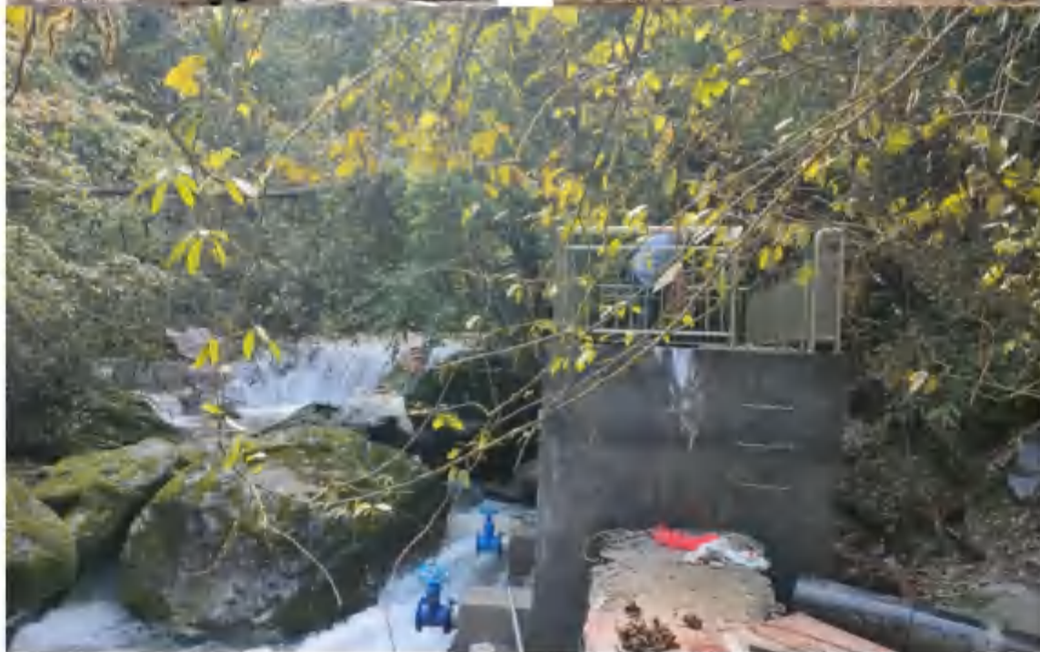
亚木沟取水口处
