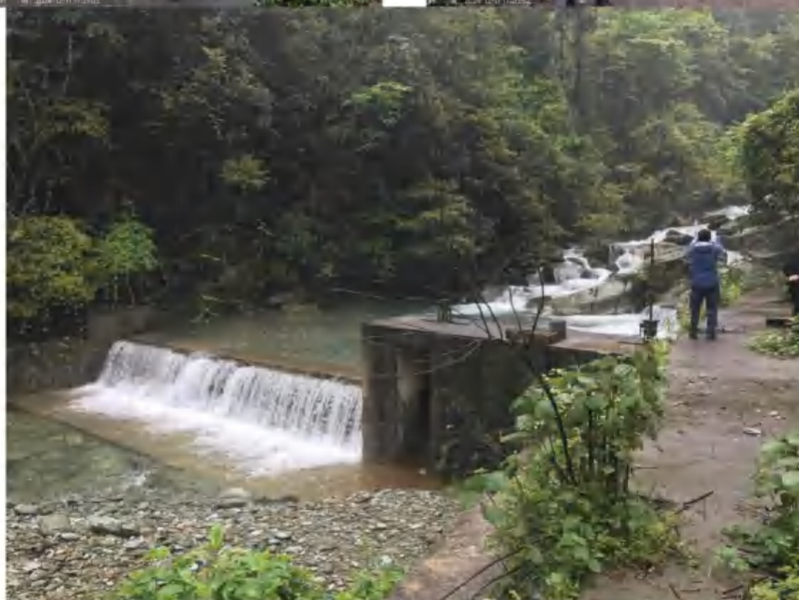
乌坡岭取水口处
