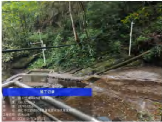
亚木沟取水坝处鱼道及生态流量泄放设施
