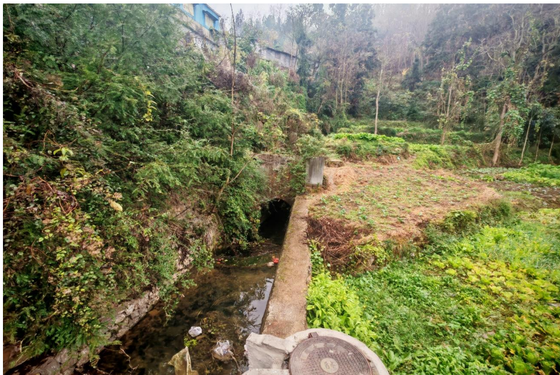
图 4.1-7 K 1 地下暗河入口及 SD 1 引水隧洞
