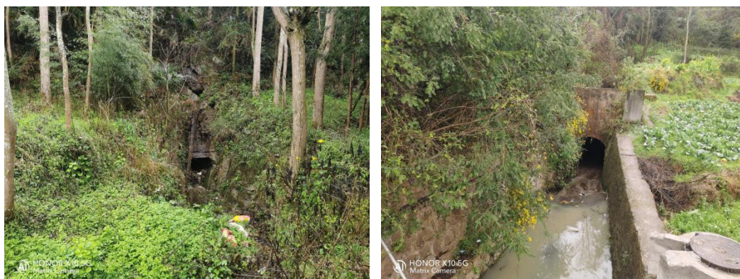
图 4.1-13 原暗河入口 K1（左）及现有引水隧洞 SD1（右）照片
