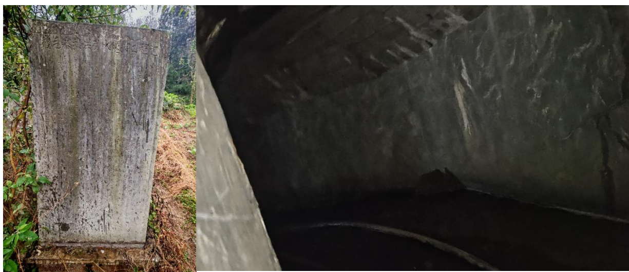
图 4.1-8 SD 1 引水隧洞立碑及洞内情况
