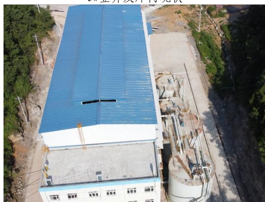
压滤车间及滤液槽
