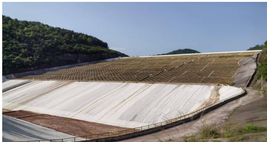
赤泥堆场大坝现场照片
