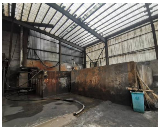
废渣暂存间水池、事故池
