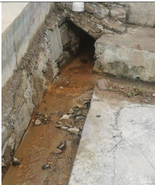
厂区地下水出露点（仅下雨时出露）
