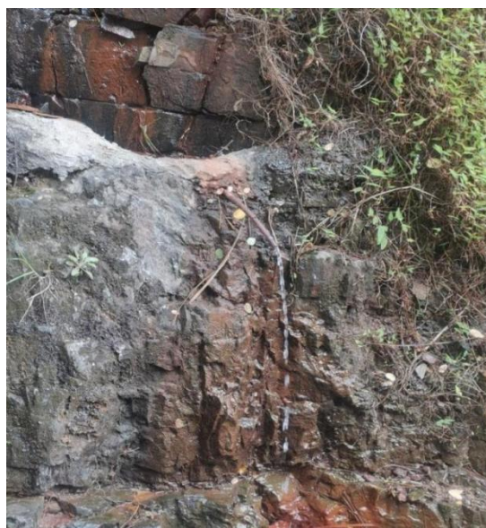
厂区地下水出露点（仅下雨时出露）
