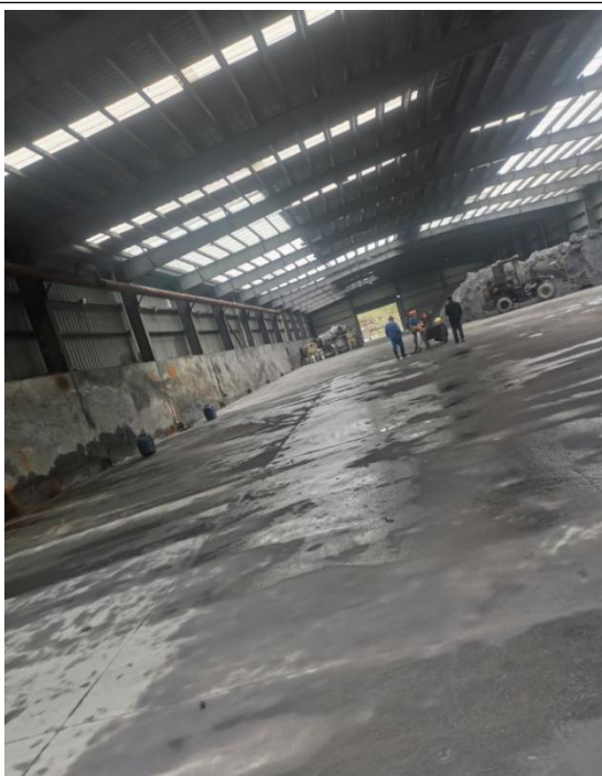
现废触媒堆放库及预处理车间
