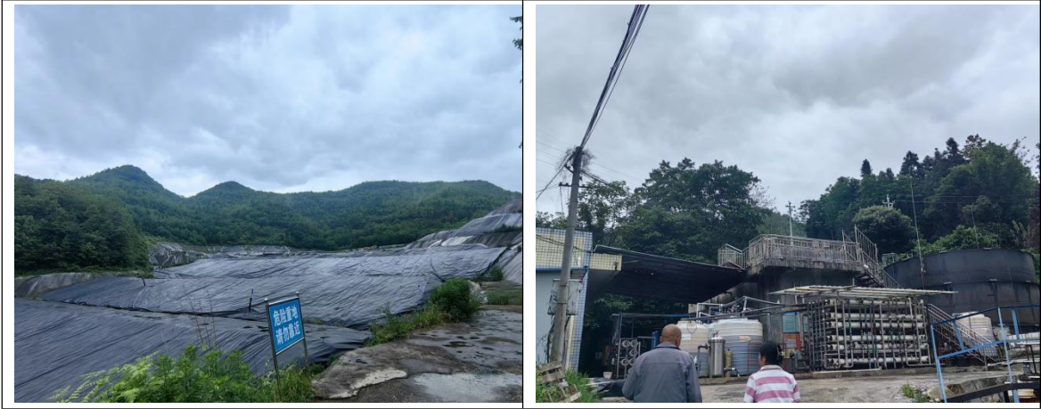
图 8.5-2 大方县生活垃圾填埋场现状
