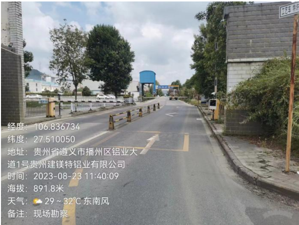
项目西侧遵义铝业厂内道路
