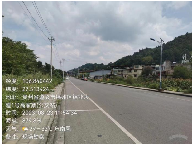
项目东北侧园区道路及居民点
