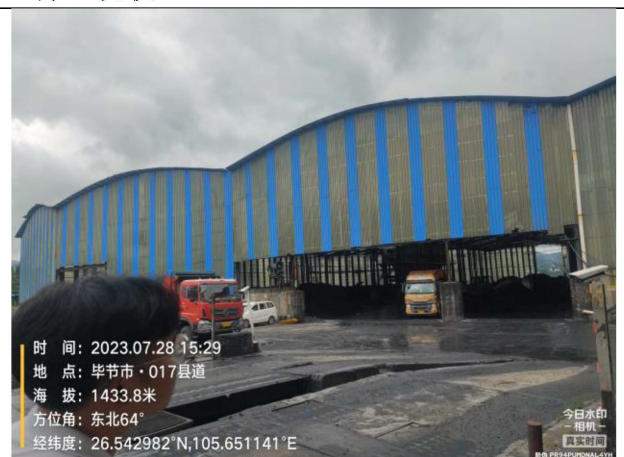
已建成全封闭储煤场
