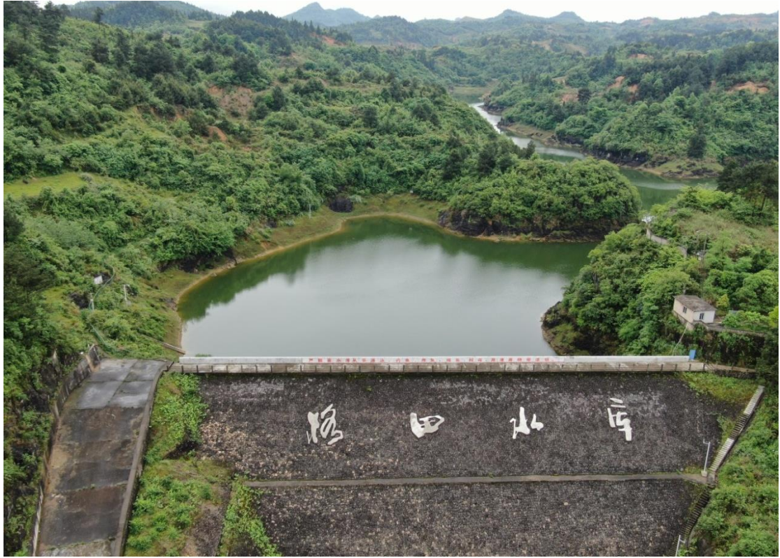
格田水库现场照片
