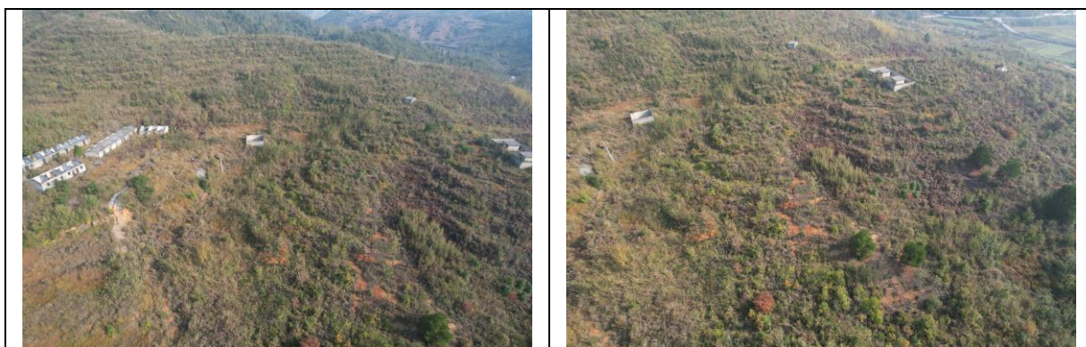
长顺县马路乡毛栗坡煤矿工业场地(现场照片)
