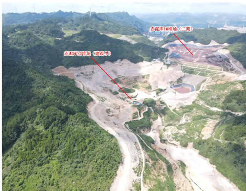
赤泥库 2#堆场现状（建设中）
