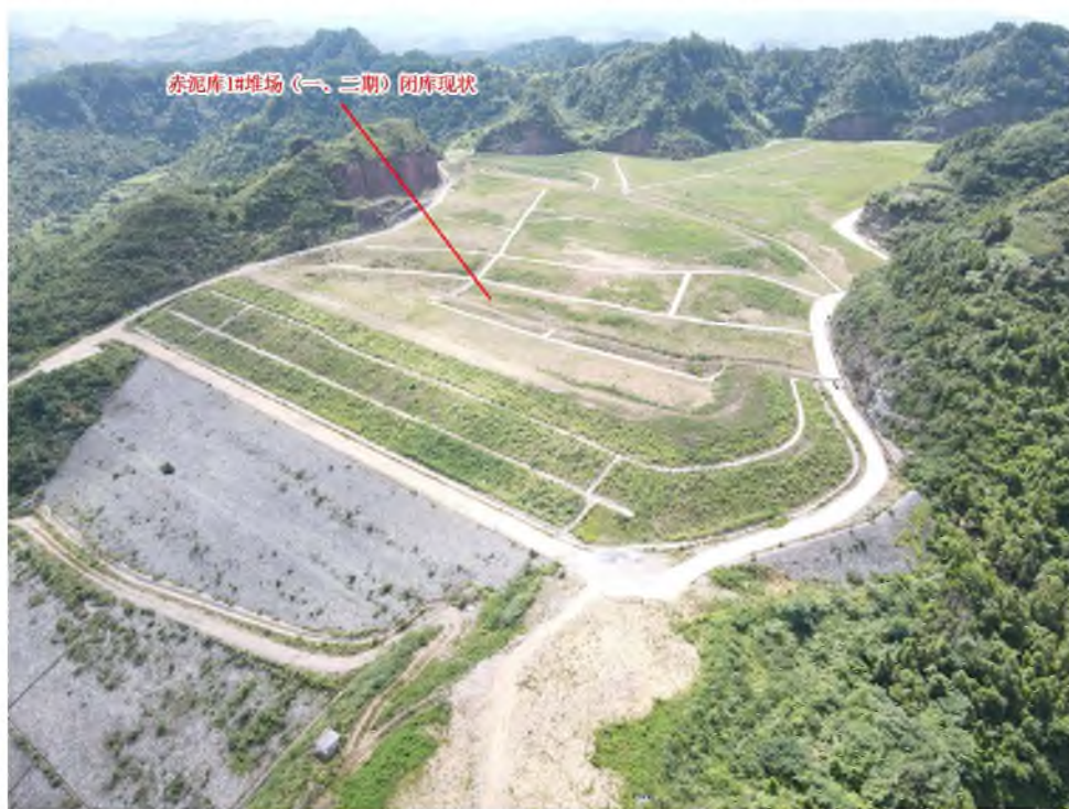
赤泥库 1#堆场（一、二期）闭库封场现状
