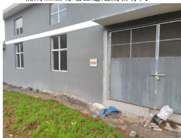
已建瓦斯泵站
