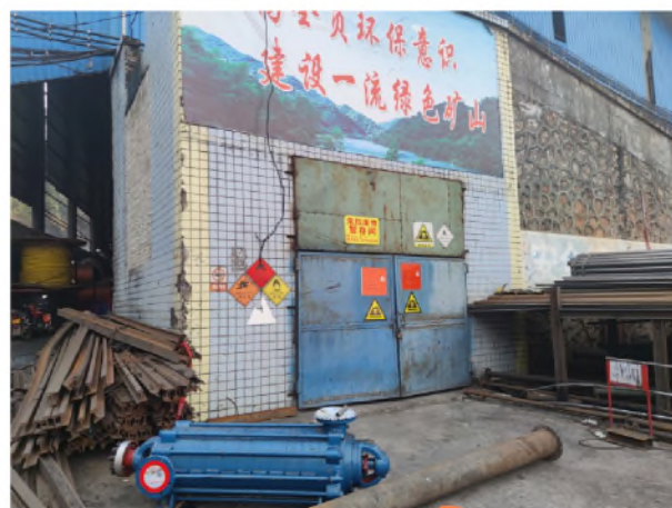
辅助工业场地已建危废暂存间
