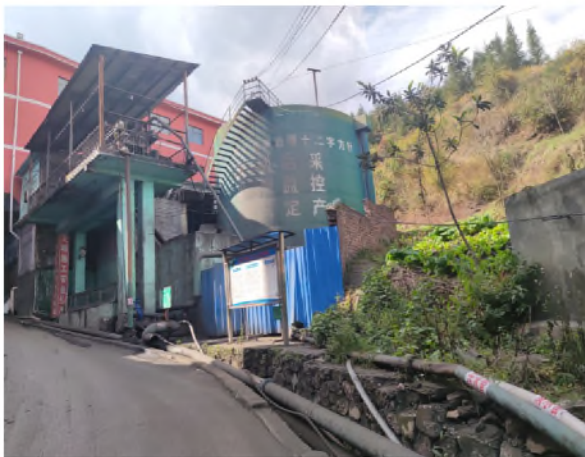
辅助工业场地已建矿井水处理站
