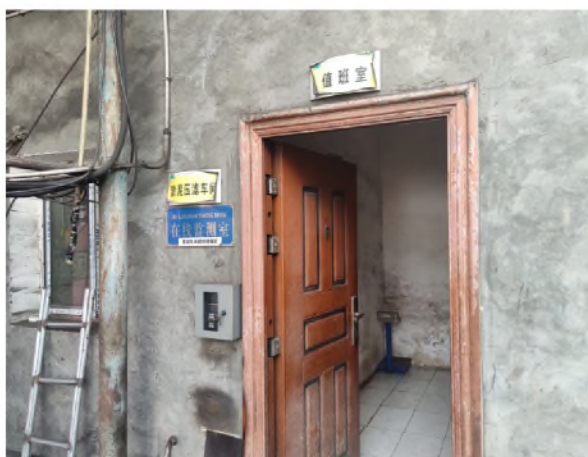
辅助工业场地在线监测室
