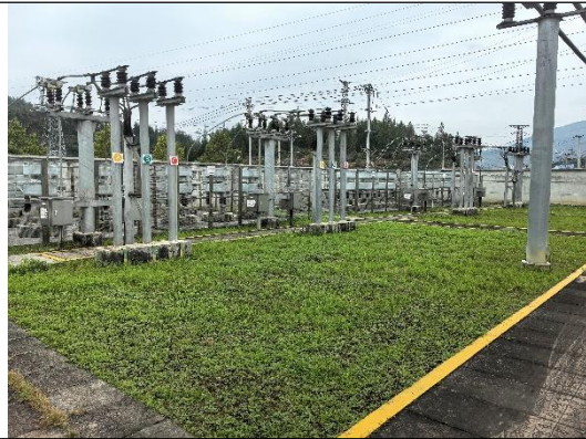
电容器组区域现状
