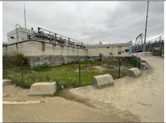
站外征地扩建消防水池区域
