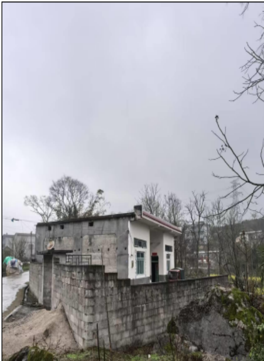
烂坝组 46 号居民住宅（吴正义家）
