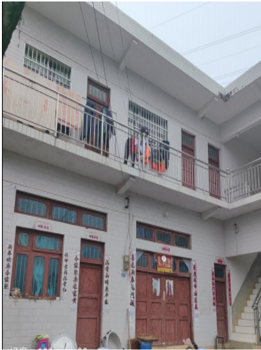
烂坝组 1 号居民住宅（卢发江家）
