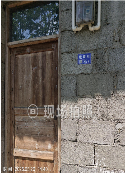
贞丰县龙兴街道烂坝组 25 号居民住宅 (吴月波家)
