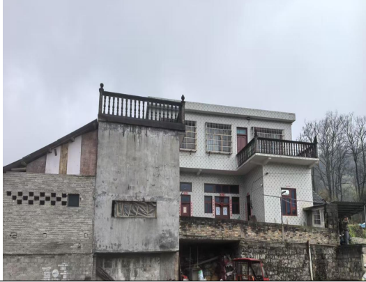
烂坝组 48 号居民住宅（吴啟贵家）
