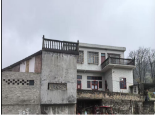
烂坝组 48 号居民住宅（吴啟贵家）
