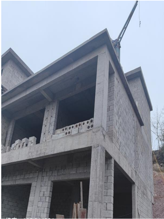
贞丰县龙兴街道烂坝组 2 号居民住宅 (吴月志家)
