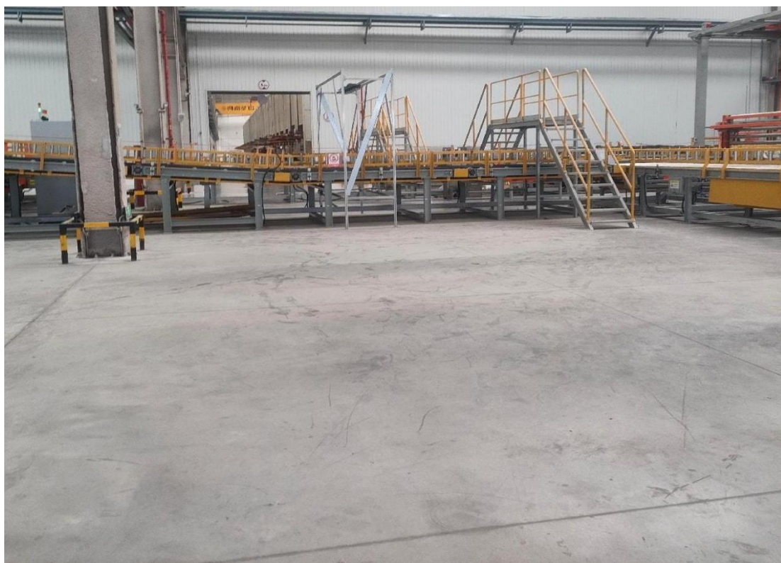
图 8-1 X 射线探伤及配套铅房拟搬迁场址现状
