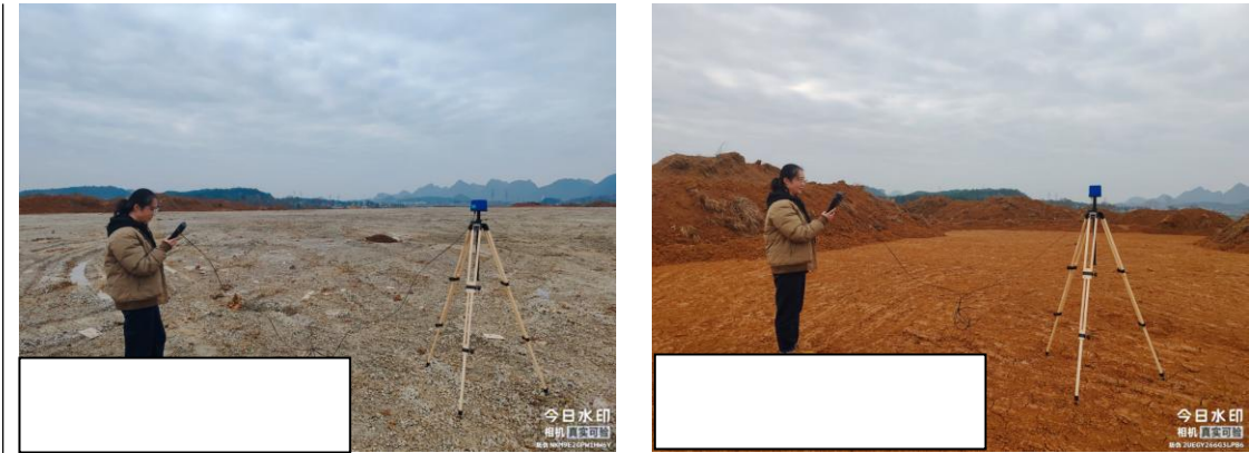
图 3.1 现状部分监测照片
