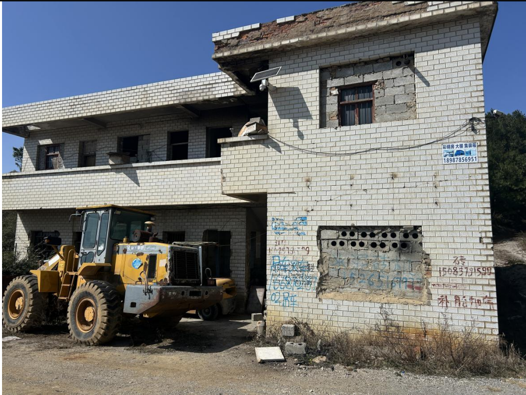
图3-4 评价区范围内居住地现场踏勘图（荒废宅基地）
