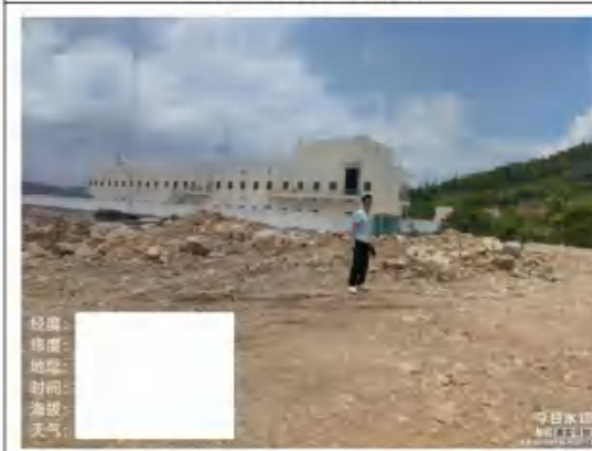
工程师现场复核照片
