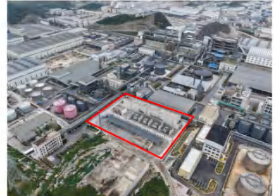
裕能 220kV 裕富变
