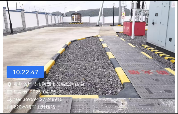
在建将军山 220kV 升压站现状
