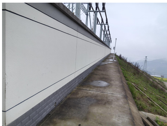
变电站西南侧护坡和植被
