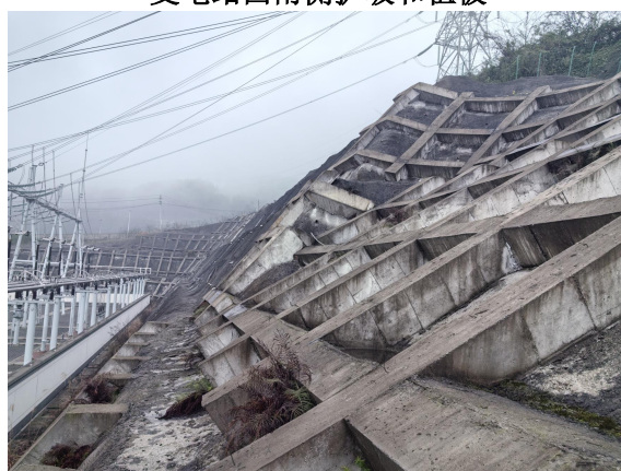
变电站东北侧护坡
