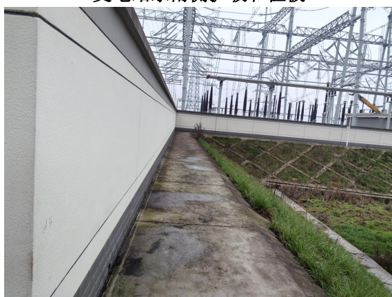
变电站西北侧护坡和植被
