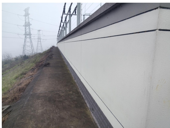
变电站东南侧护坡和植被
