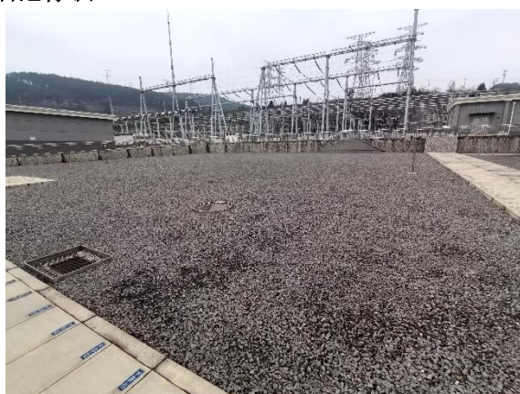
本期低压电容器扩建预留场地
