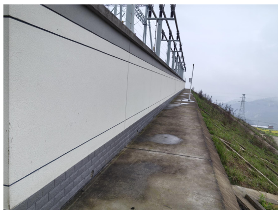
变电站西南侧护坡和植被
