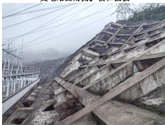
变电站东北侧护坡
