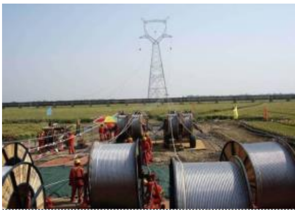
图 3-2 线路工程沿线牵张场布置形式照片
