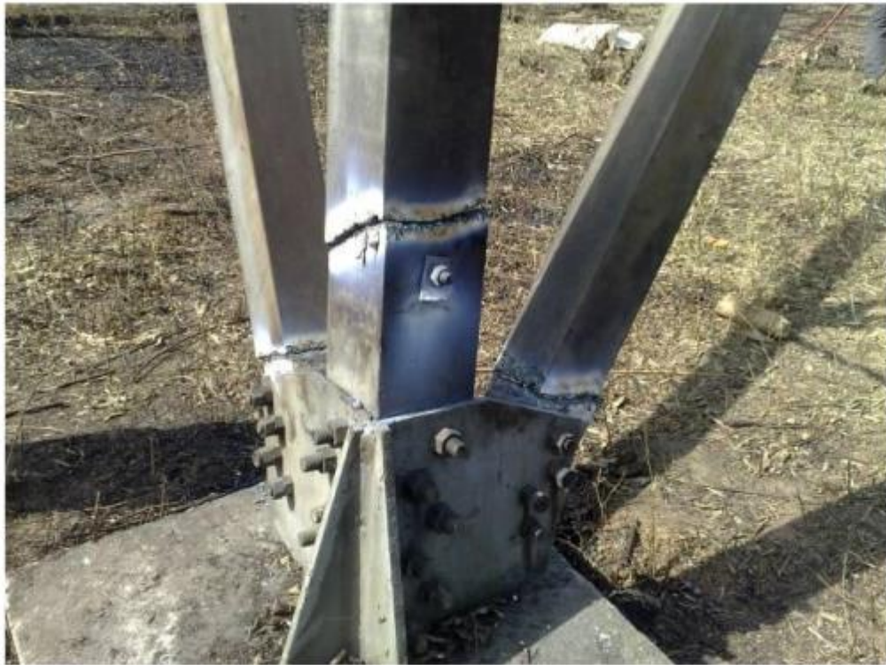
图 3-4 塔腿主材及八字铁切割工程实景图
