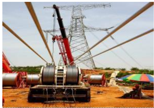
图 3-2 线路工程沿线牵张场布置形式照片
