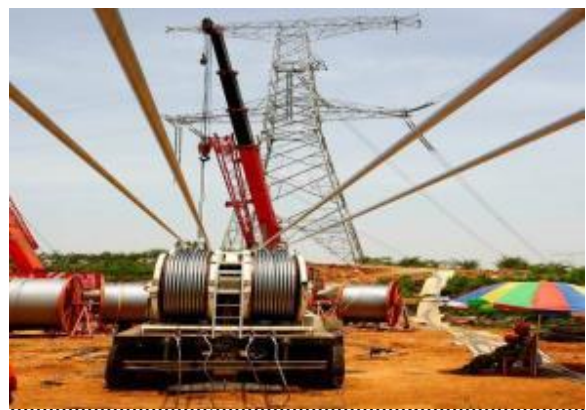
图 3-2 线路工程沿线牵张场布置形式照片
