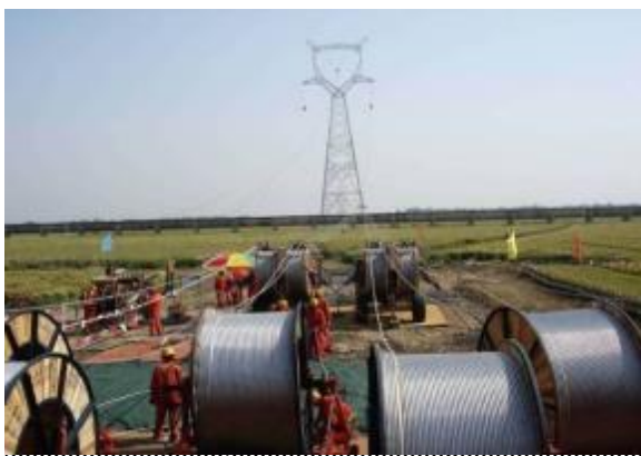
图 3-2 线路工程沿线牵张场布置形式照片
