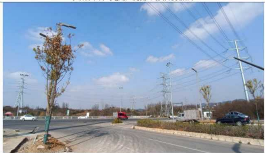
本项目线路 \pi 接点处现状照片
