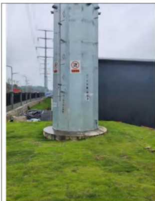
钢管杆塔基恢复照片
