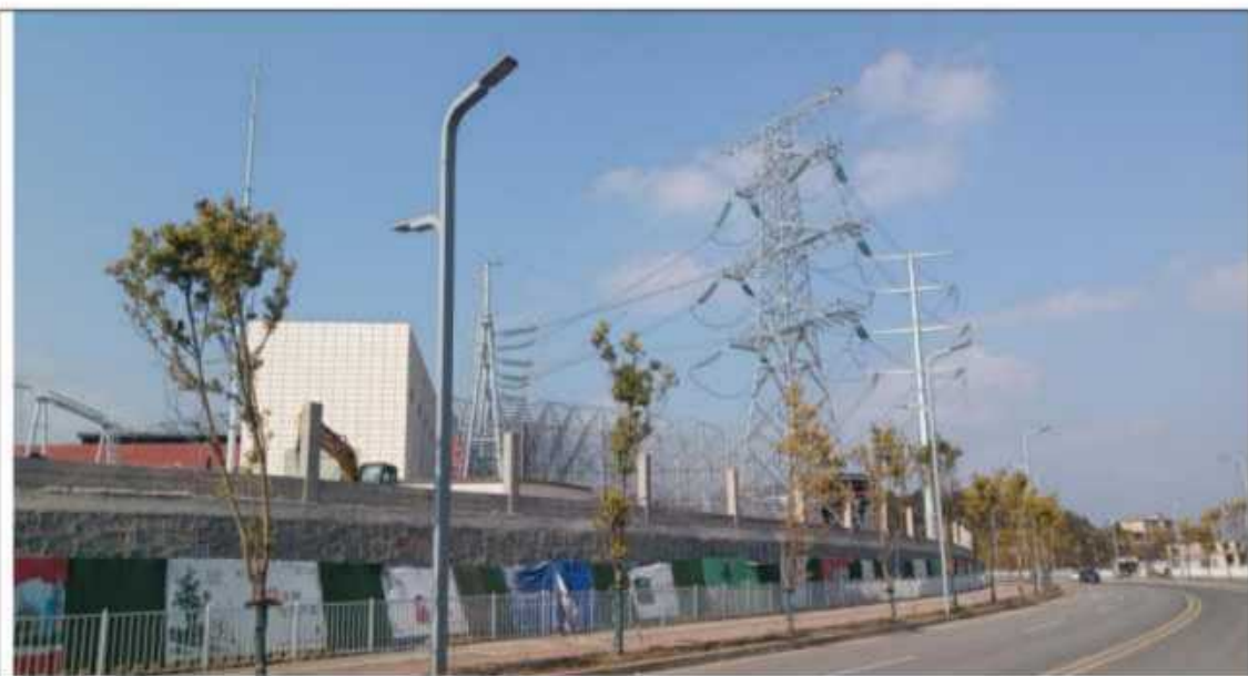
本项目中科气电用户变侧终端塔现状照片
