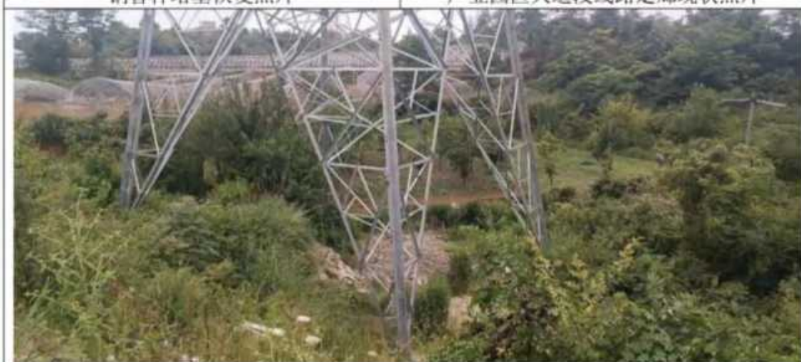
铁塔塔基恢复照片
