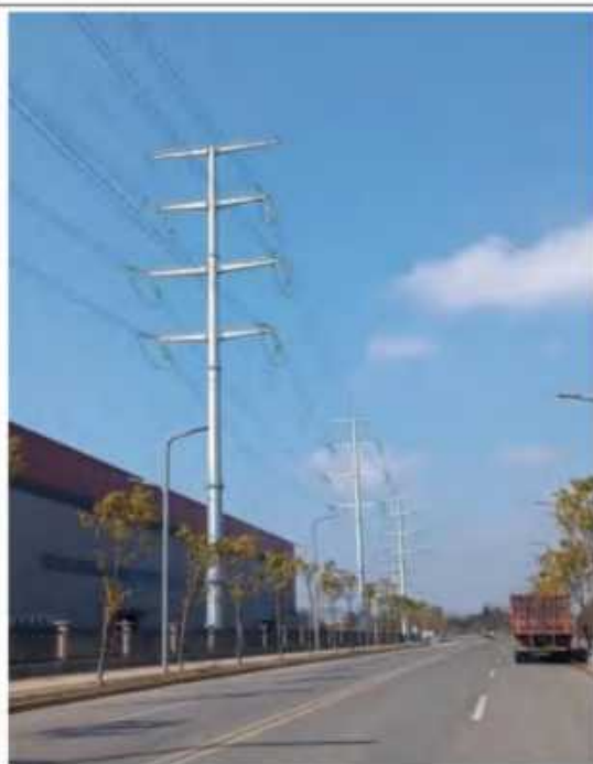
产业园区大道段线路走廊现状照片
