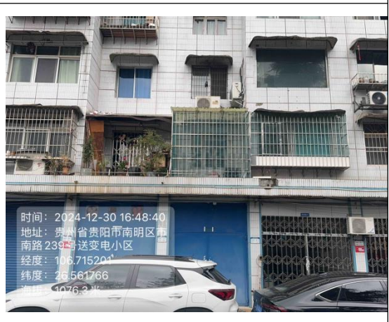
现有移动 X 射线探伤机储存位置大门楼顶
