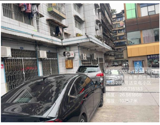
现有移动 X 射线探伤机储存位置北侧现状
