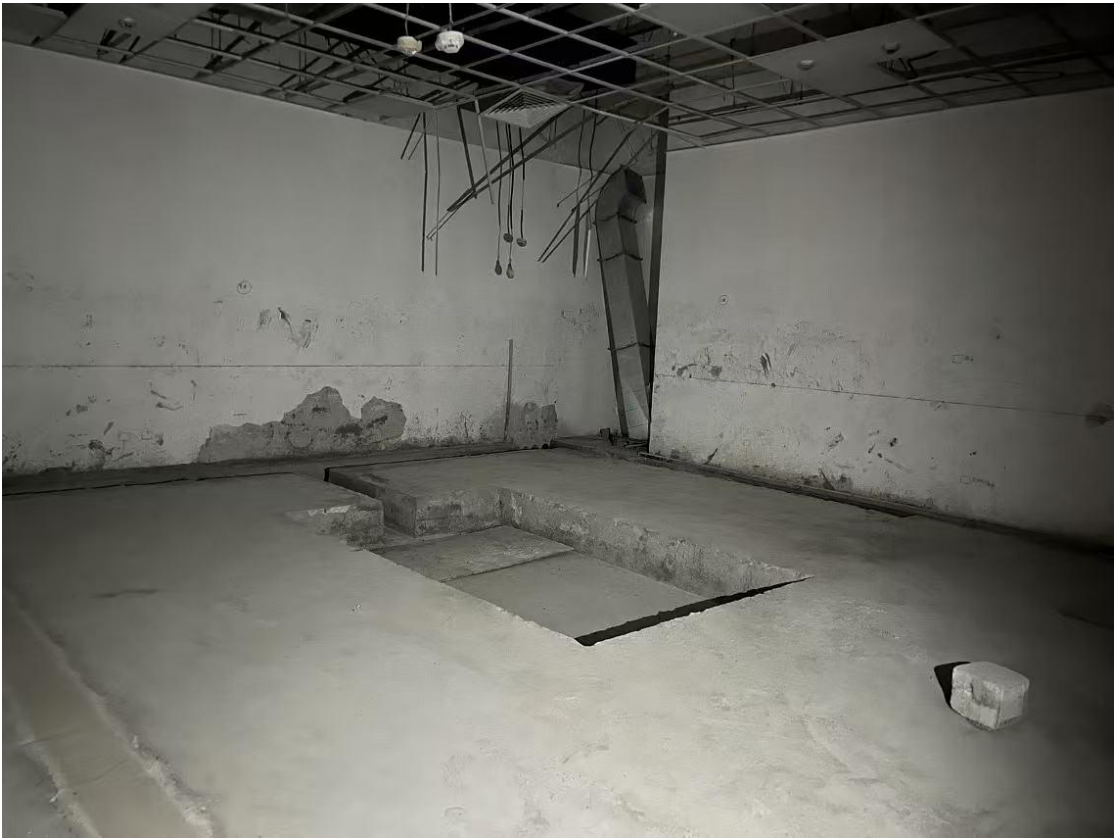
图 8-1 医用直线加速器机房现状图
