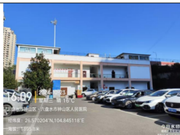
(3) 项目所在楼栋及其西侧停车场
