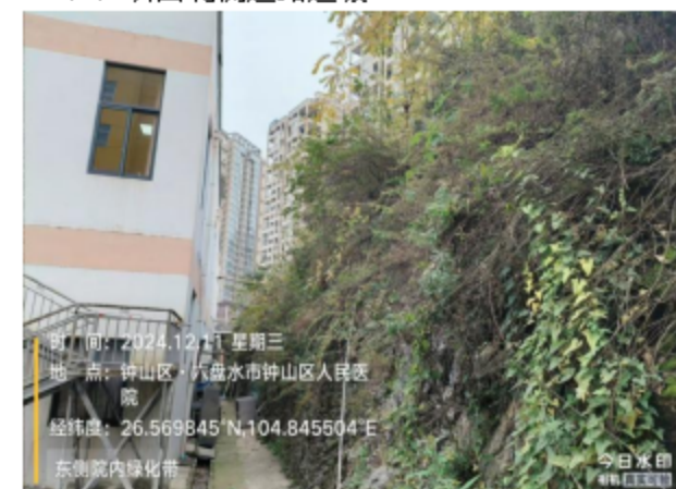
(6) 项目东侧所在楼栋一层及东侧空地、泥土层
