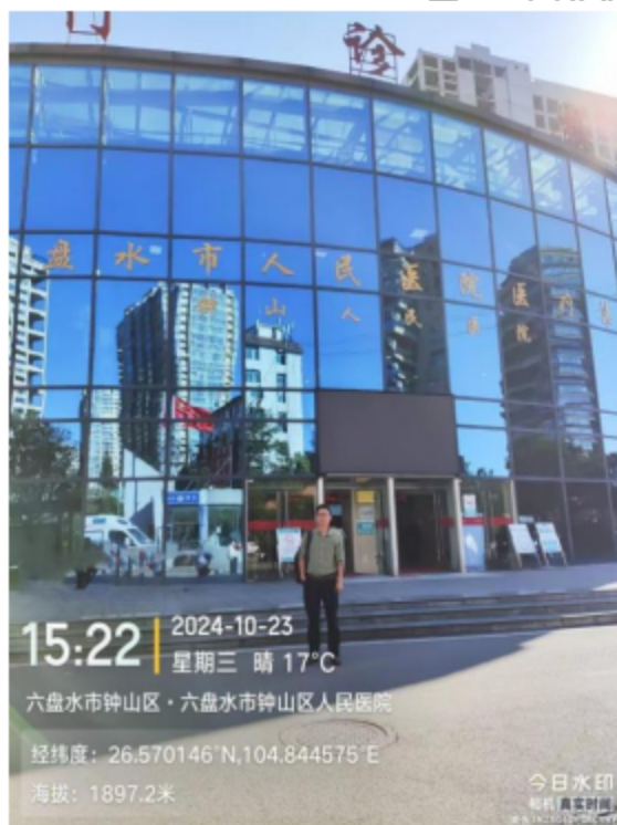
(1) 医院门诊楼 (项目西侧)
