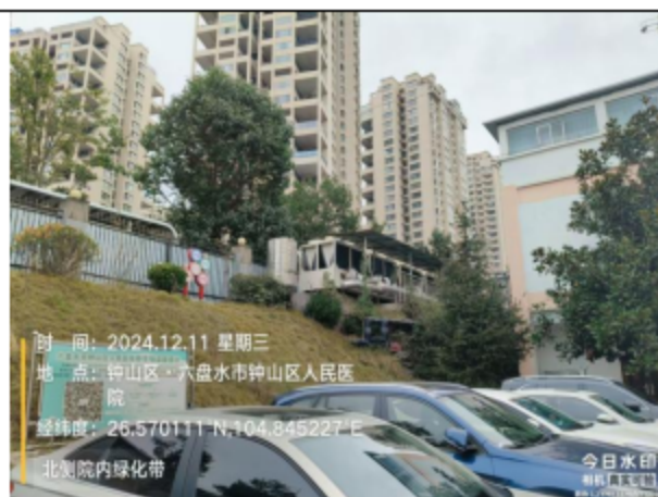
(4) 项目北侧道路边坡
