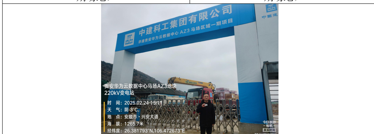
环评工程师现场图片 5（项目所在 AZ3 一期场地）
