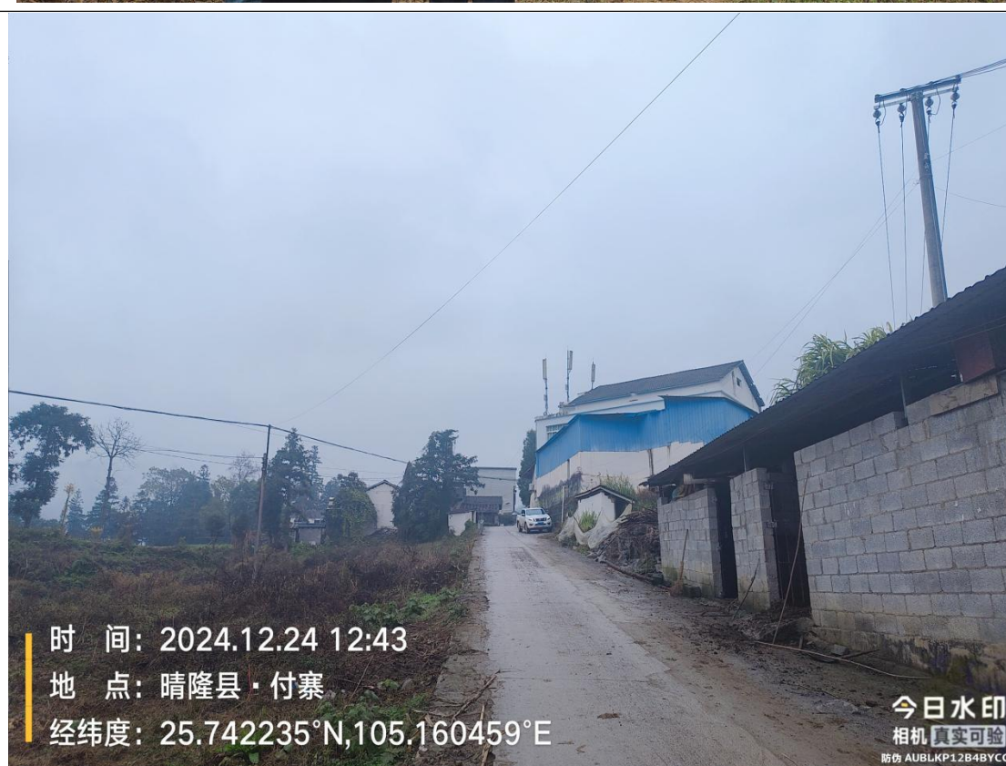
升压站场地现状及项目工程部位位置
