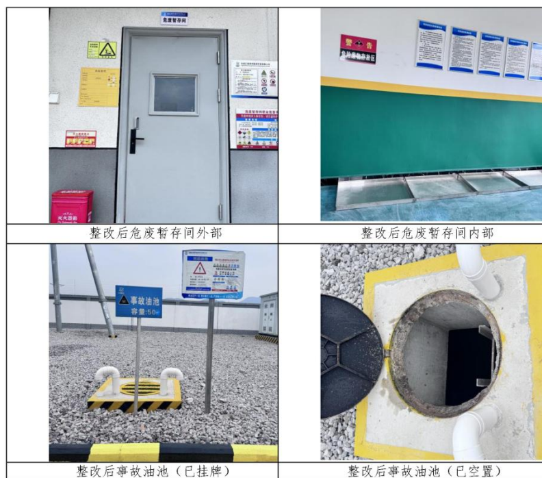
图 1 升压站内整改图
