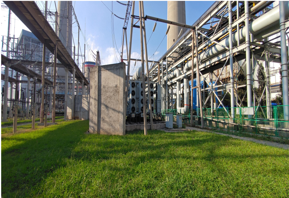
图 4-2 施工临时占地恢复现状照片
