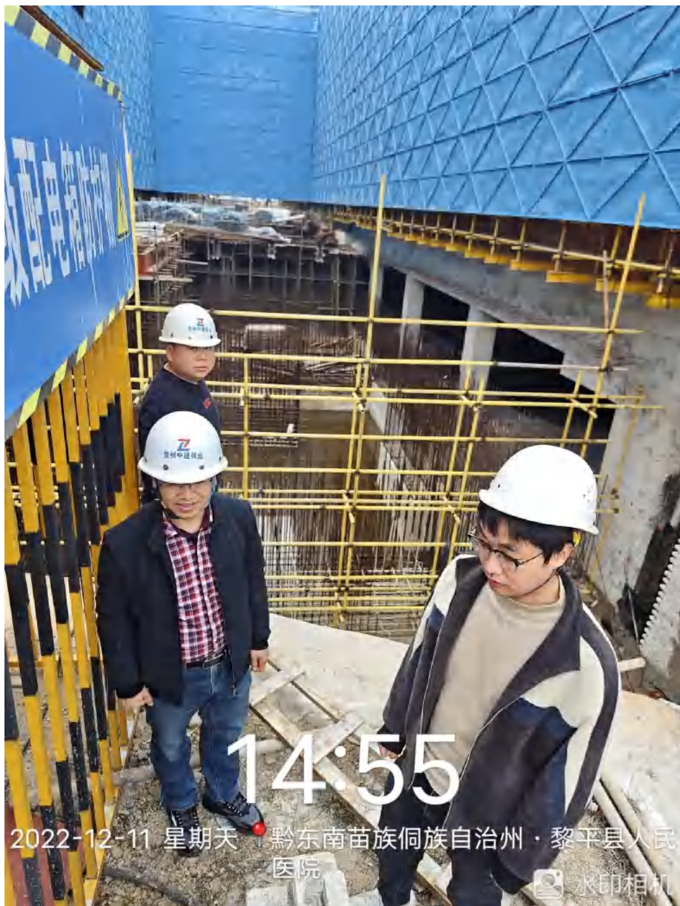
直线加速器和后装机所在上方路面
