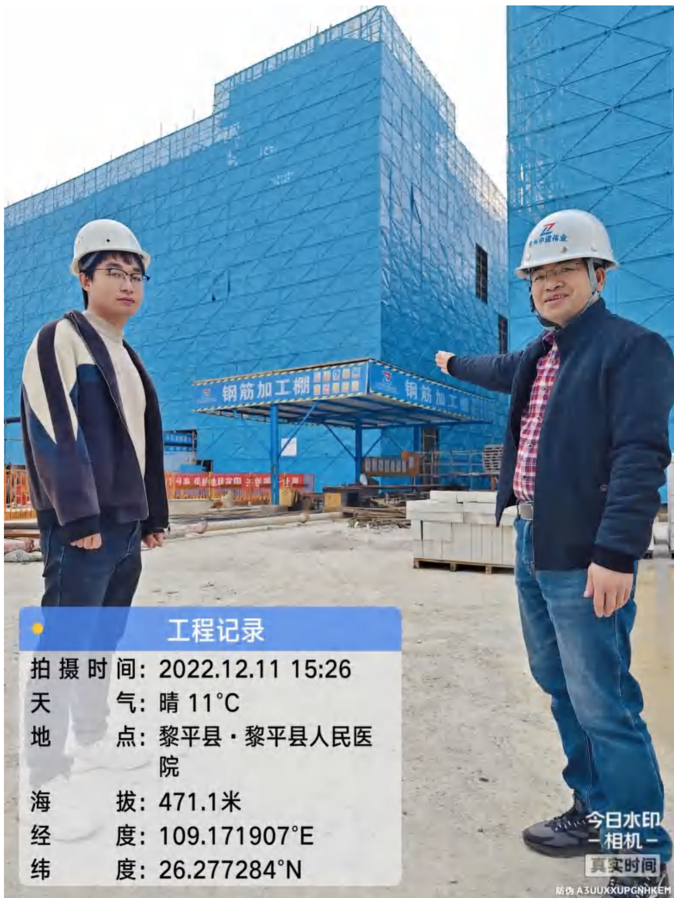
拟建 DSA 机房所在医技楼位置
