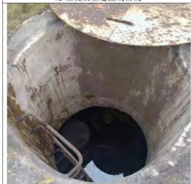
厂区事故池现状 130m 3
