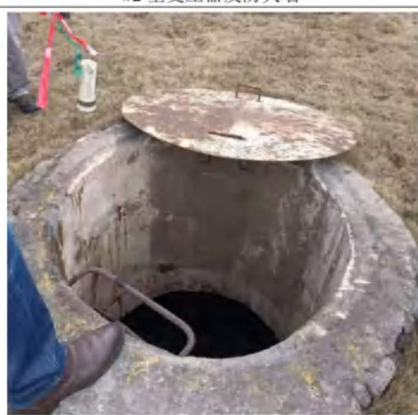
厂区事故池现状 130m 3
