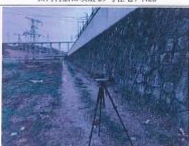
220kV 凤山变电站出线间隔处 N29
