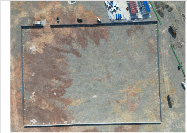
马场坪 220kV 变电站站址
