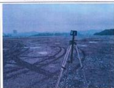
马场坪 220kV 变电站站址西侧 T3
