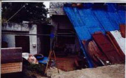
Pic4 王生辉住宅
