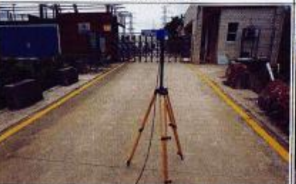
Pic7 变电站断面检测 1
