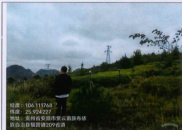
中核紫云 200MW/400MWh 储能项目站址北侧
