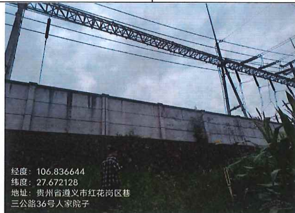
220kV 下坝变电站西北侧围墙间隔
