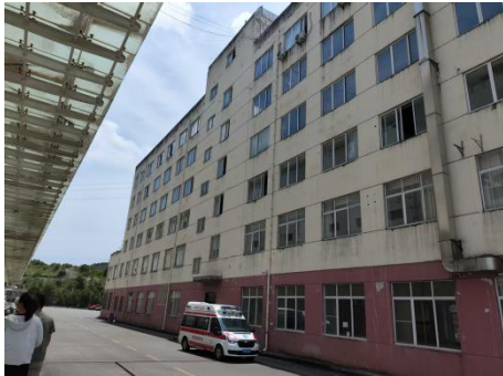
拟建暂存库南侧道路和办公楼
