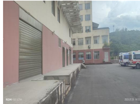
拟建暂存库西侧月台和装卸货区
