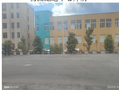
物流配送中心西侧装卸货区
